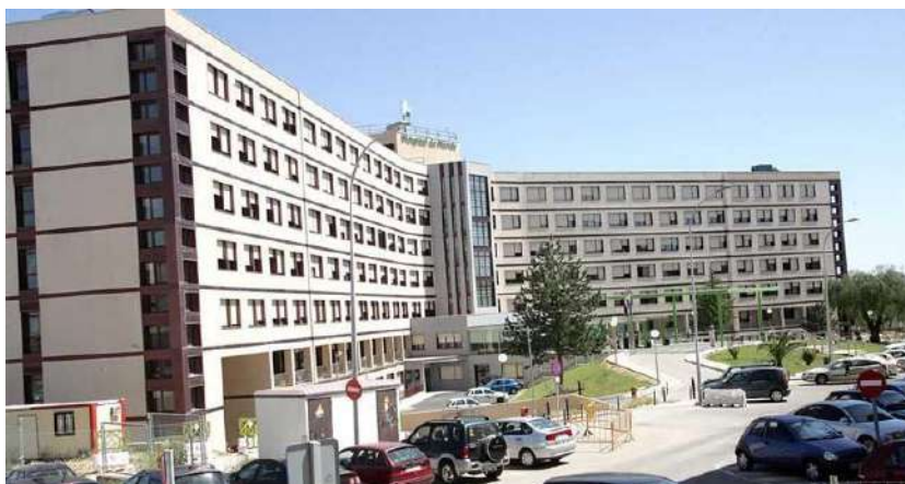
Figura 40. Hospital de Mérida
