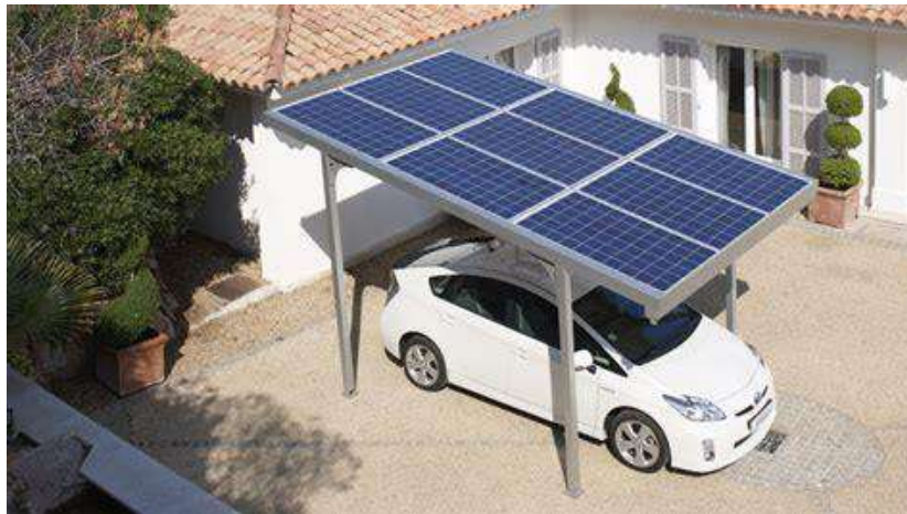
Figura 49. Sistema de carga fotovoltaico instalado en aparcamiento privado
