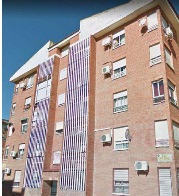
Figura 45. Sistema de protección solar fotovoltaica orientable
