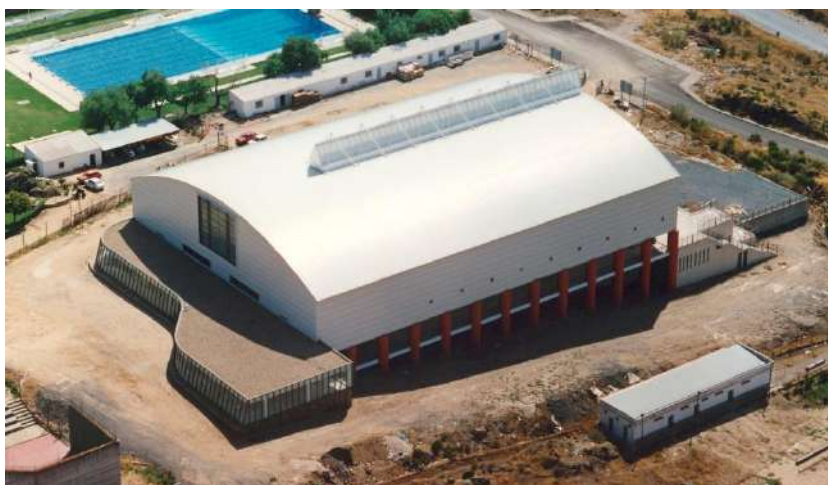
Figura 41. Pabellón polideportivo, en Plasencia
