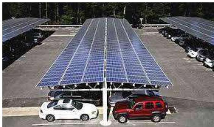
Figura 48. Sistema de código abierto para carga fotovoltaica de vehículos
