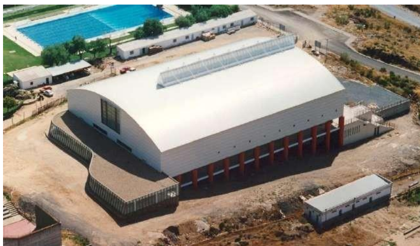
Figura 41. Pabellón polideportivo, en Plasencia
